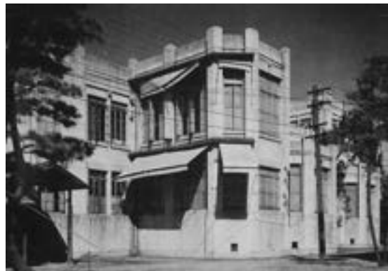
新装成れる熊本医科大学附属醫院外科手術室外観
